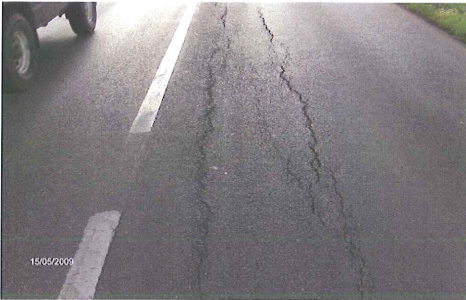
Fissures longitudinales
