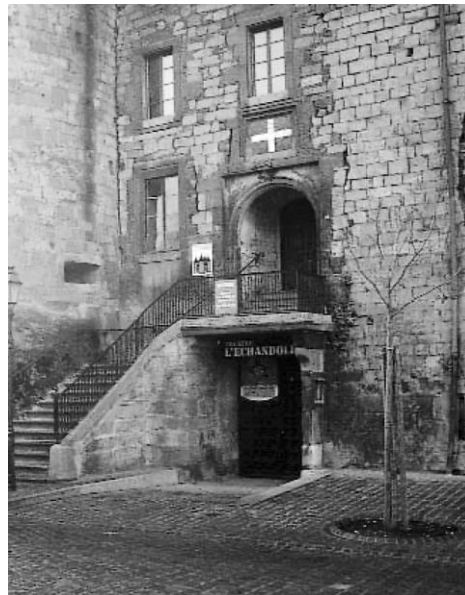
Vue de la façade nord à la fin des années 1980
